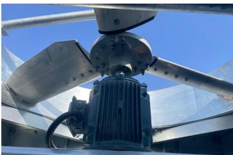
传统冷却塔设备通过定频感应电机配合皮带轮或齿轮箱实现长期的低速运行, ABB 可以为冷却塔应用提供低速大扭矩的永磁直驱方案。
